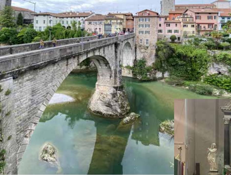
Cividale del Friuli (UD) Il ponte del Diavolo sul fiume Natisone.
